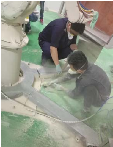
图二：孙永付在现场使用磨光机打磨地面上坚硬的氮化硅污垢
