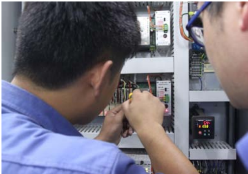
多晶炉水流量红色报警处理：这个螺帽得拧拧紧
